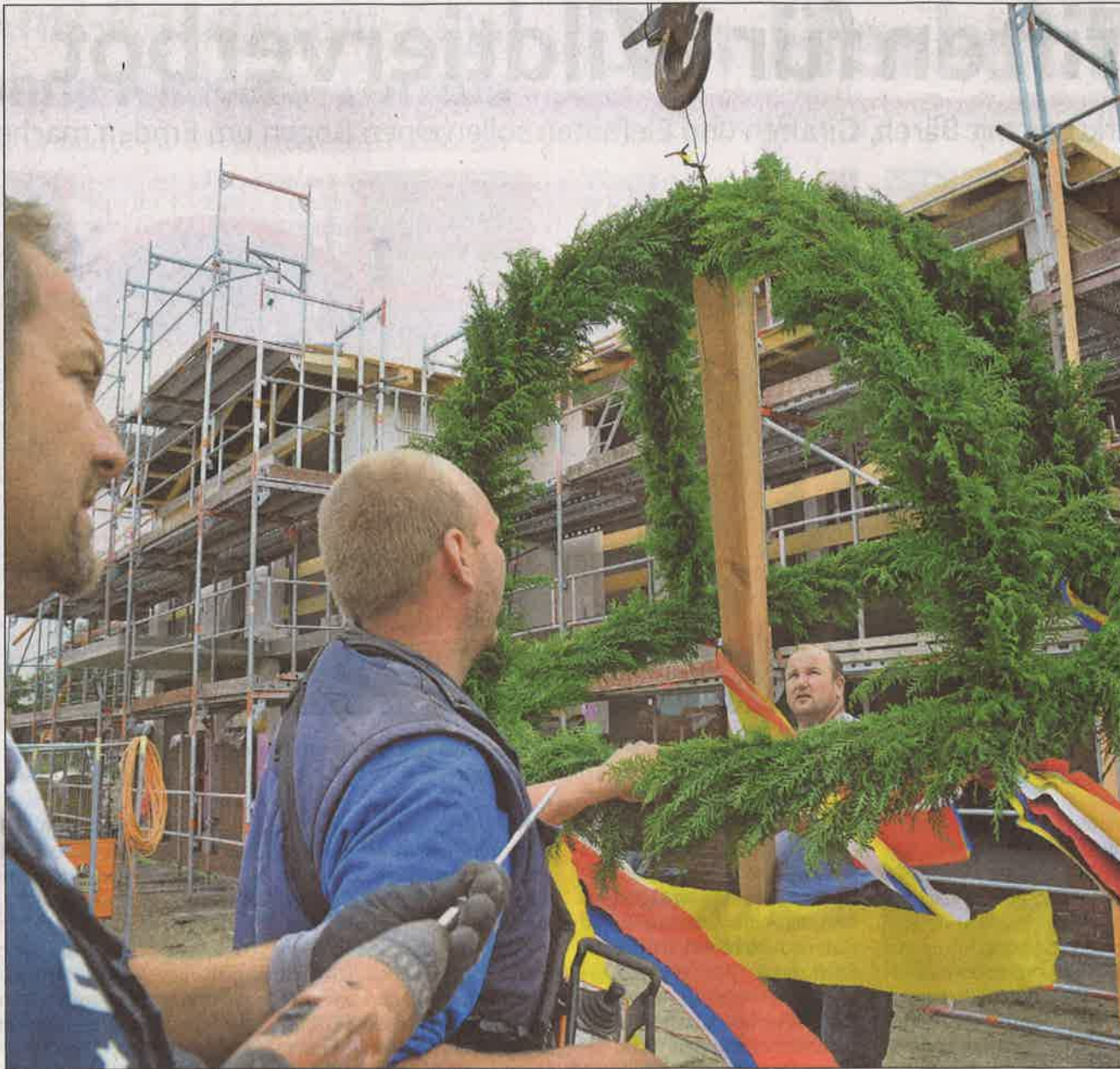
Auf den Haken genommen: Per Kran wurde der Richtkranz gestern am Wykhoffweg hochgehievt. Dort sollen bis zum Frühsommer 2017 fünf Gebäude mit 34 Wohneinheiten unter der Maßgabe „Bezahlbarer Wohnraum“ entstehen.
