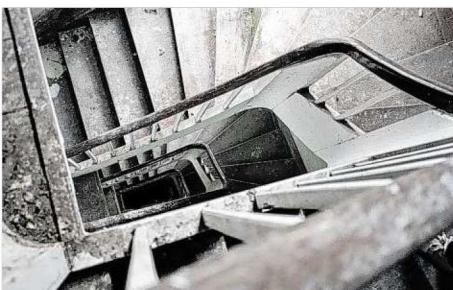
Fünf Geschosse hat das Gebäude.
