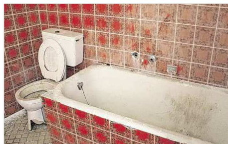
Das Badezimmer einer Wohnung ist noch komplett.
