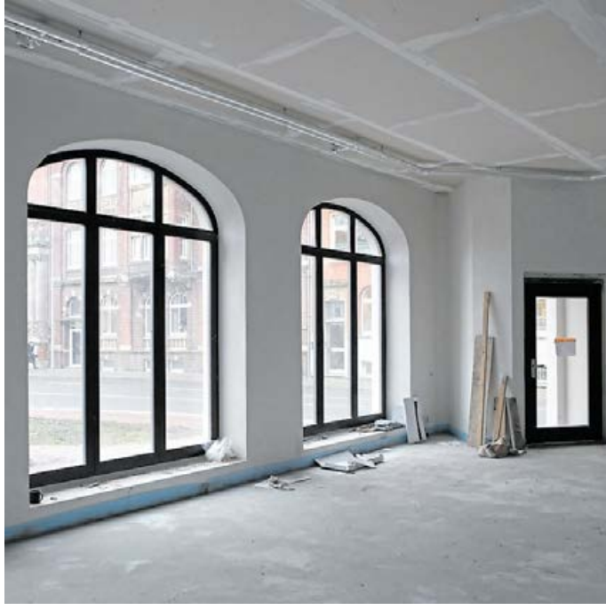
Um dem neuen Gastronomen alle Möglichkeiten zu gewährleisten, wurde dieser Bereich nur als Rohbau fertig gestellt.
