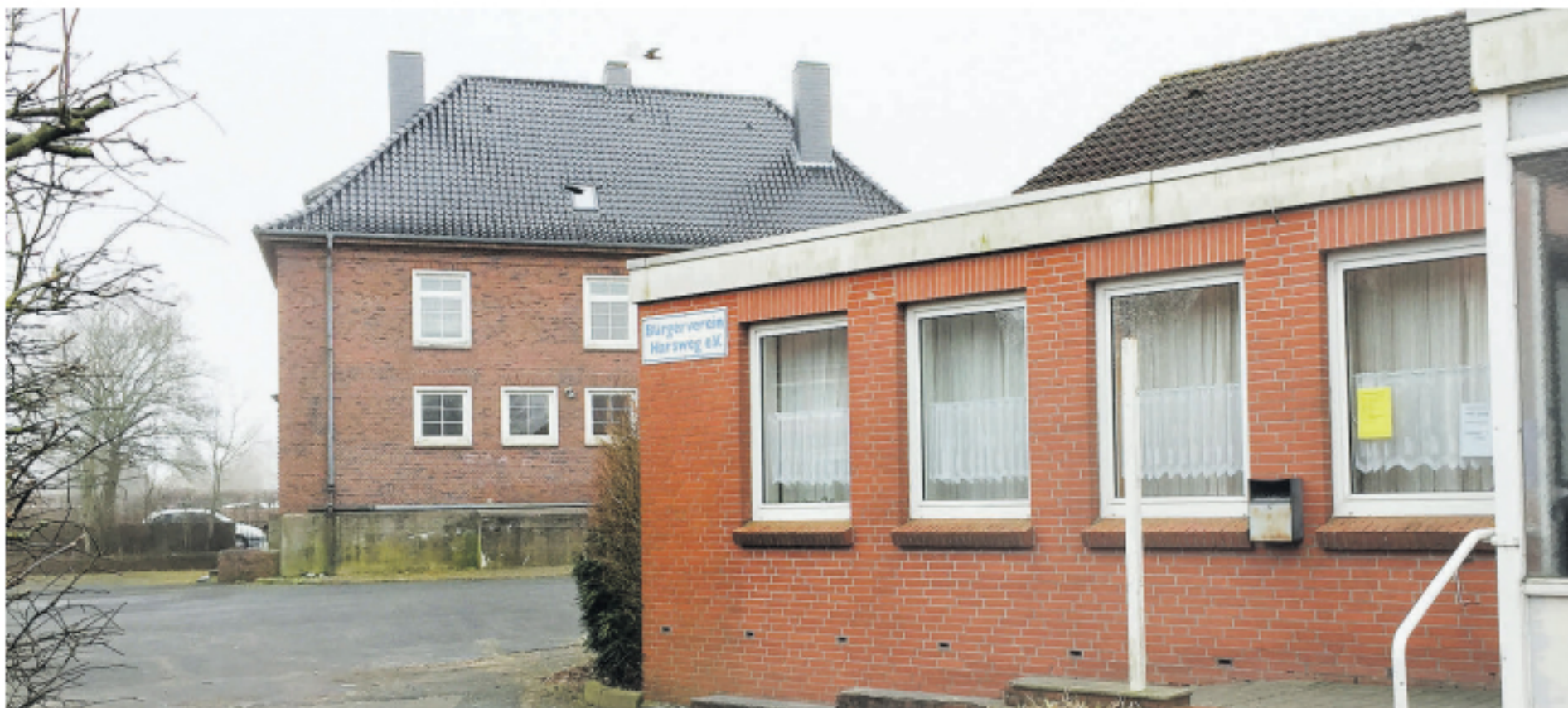
Ein Bild aus dem Jahr 2020, als der Bürgerverein noch im Turnhallengebäude (vorne) zu Hause war: Schon damals gab es Verkaufspläne für das Gelände der alten Schule in Harsweg.
