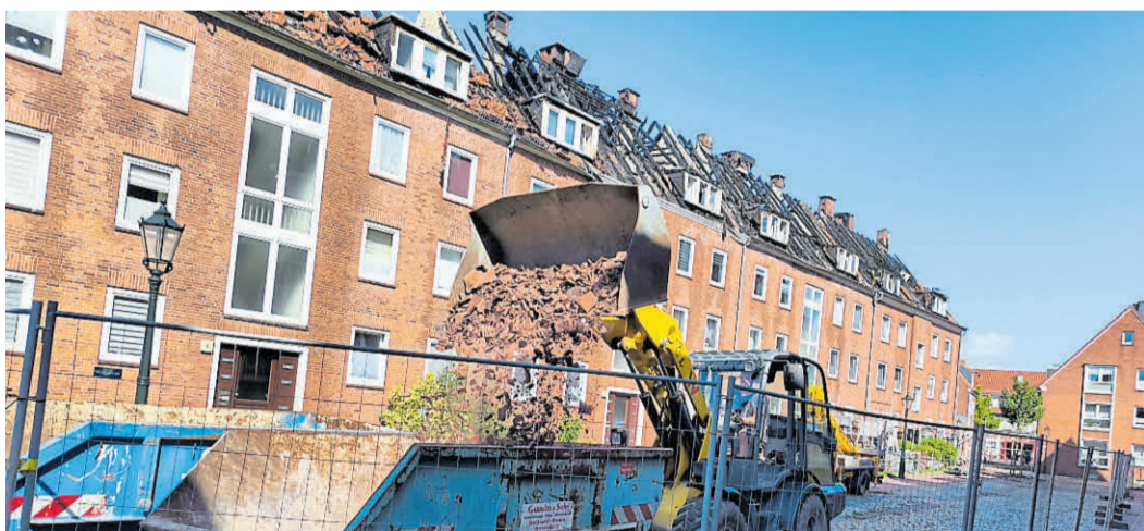
Die Aufräumarbeiten sind am Montag angelaufen: So wurde etwa Schutt abgefahren.
