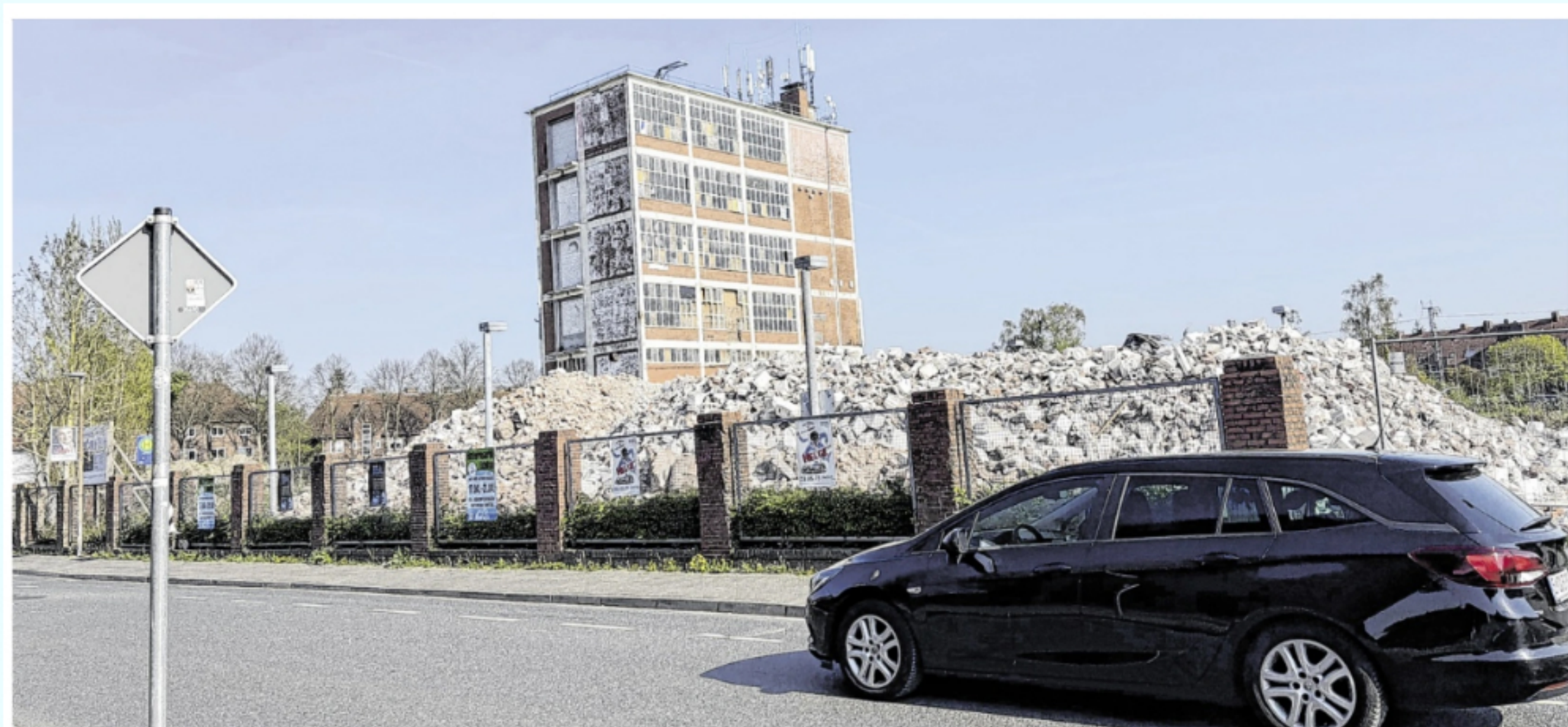
Ganz viel Bauschutt liegt vor dem Ültje-Turm.
